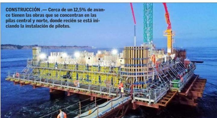
**CONSTRUCCIÓN** — Cerca de un 12,5% de avance tienen las obras que se concentran en las pilas central y norte, donde recién se está iniciando la instalación de pilotes.
